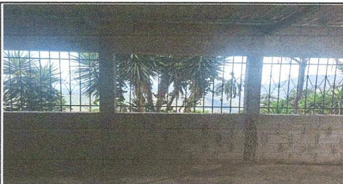
Foto 4: Mejoramiento de balcones
