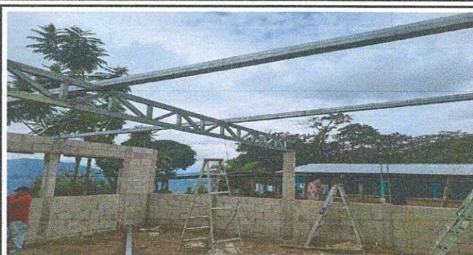
Foto 2: Mejoramiento de estructura y cubierta de lámina
