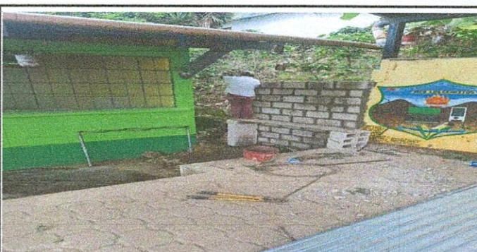
Foto 6: Mejoramiento muro perimetral
